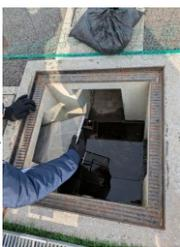
▶小櫃堰(おびつぜき)公園のテニスコート落ち葉対策として ①U字溝に蓋をする。②U字溝にごみを防ぐ目の荒いネット設置 ③集水溝に洗濯ネット、さらに、不織布を設置。④利用者に呼びかけ看板を設置し、掃除の仕方を掲示⑤テニスコート出入口にマットを敷く。
